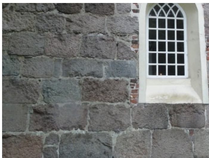
Aan de onderkant van een aantal stenen is een gekartelde rand te zien. Dit zijn boorgaten die zijn gemaakt om de steen te splijten.
